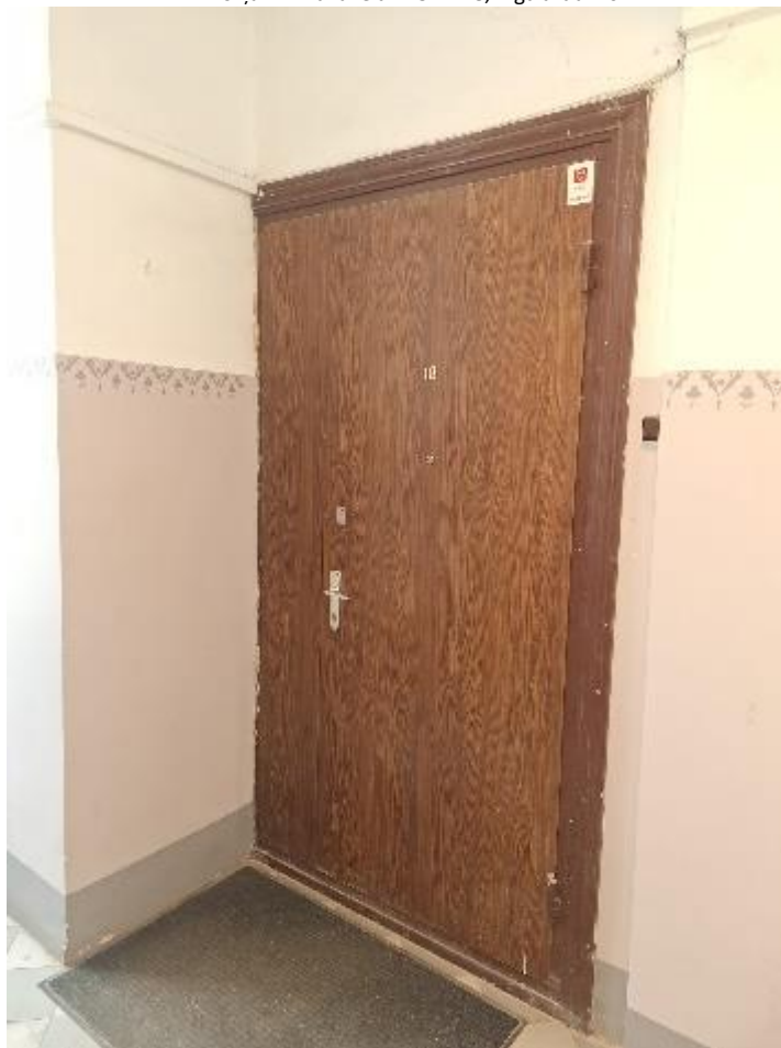
Dzīvokļa Dzirnavu ielā 115A - 18, Rīgā ārdurvis
